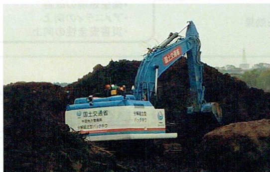
遠隔操縦式(分解組立)バックホウによる土砂撤去 (阿蘇大橋周辺)
