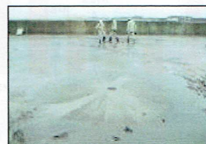
【液状化被害状況】
